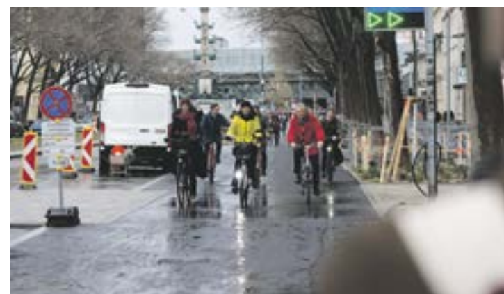
In Zukunft wird auf dem 4,5 Meter breiten Radweg sicher geradelt.
